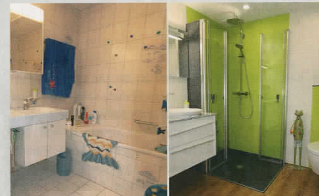
Vorher: Rutschige Badewanne mit hohem Einstieg, rissigen Fugen und schwer zu reinigende Oberflächen.
